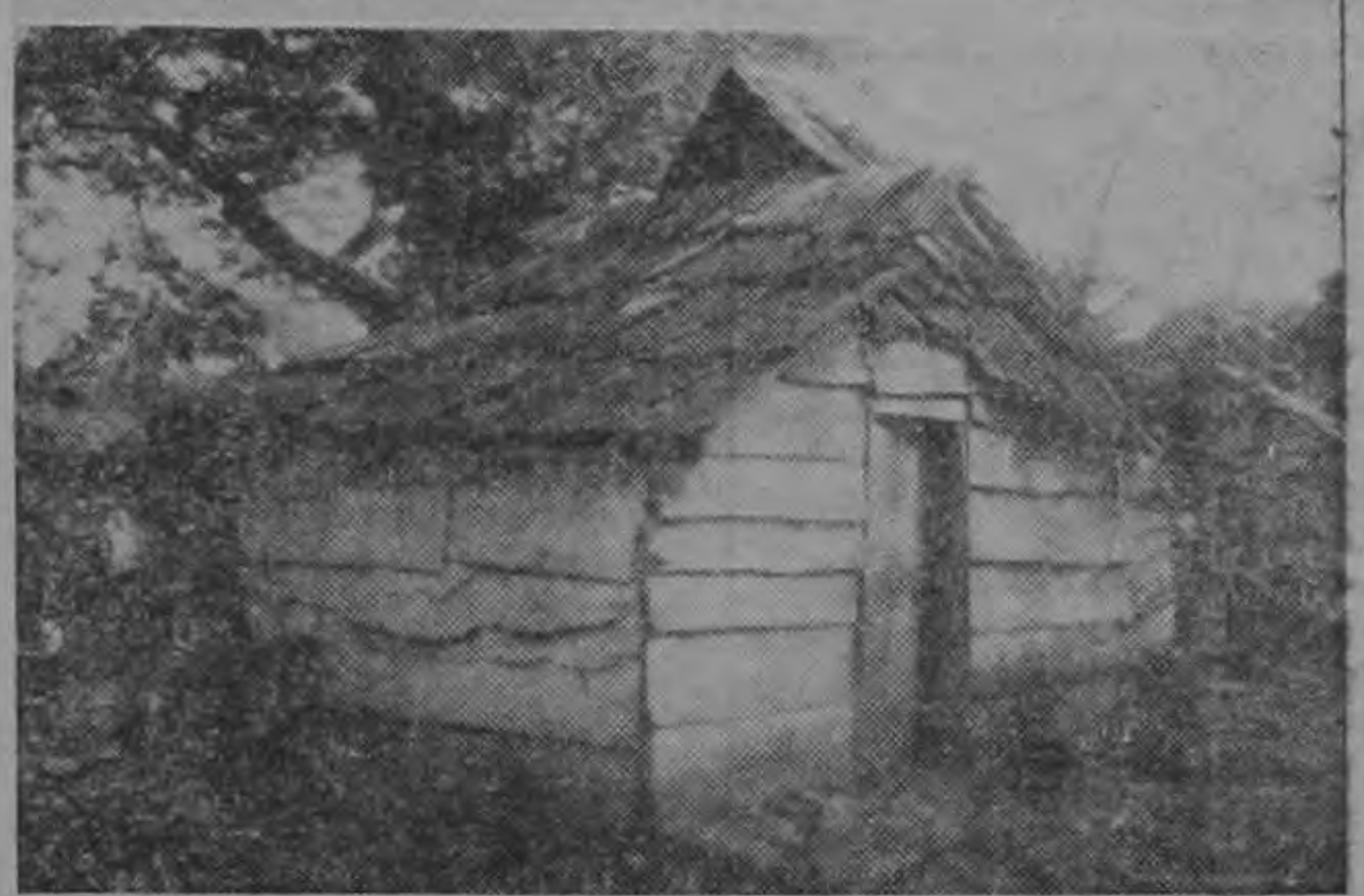
ESTOS RANCHOS QUE OCUPABAN los damnificados por las inundaciones del año 54, situados a las orillas del río Cañas, serán demolidos en breve. La zona se ha declarado inhabitable. Sus condiciones son pésimas y malsanas.
